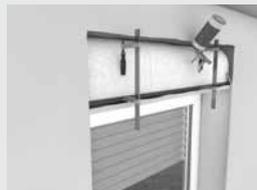
**6** Far entrare ROKA-THERMO-FLEX nel cassonetto dell'avvolgibile, inserendolo nell'intaglio della preforma della calotta di copertura.
