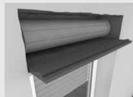
**3** Tagliare ROKA-THERMO-FLEX secondo le misure (fare attenzione al foro di passaggio cinghia e al cavo motore).
