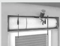
**7** Incollare i pannelli di isolamento all'architrave e chiuderle con schiuma di montaggio nella zona di giunzione.
